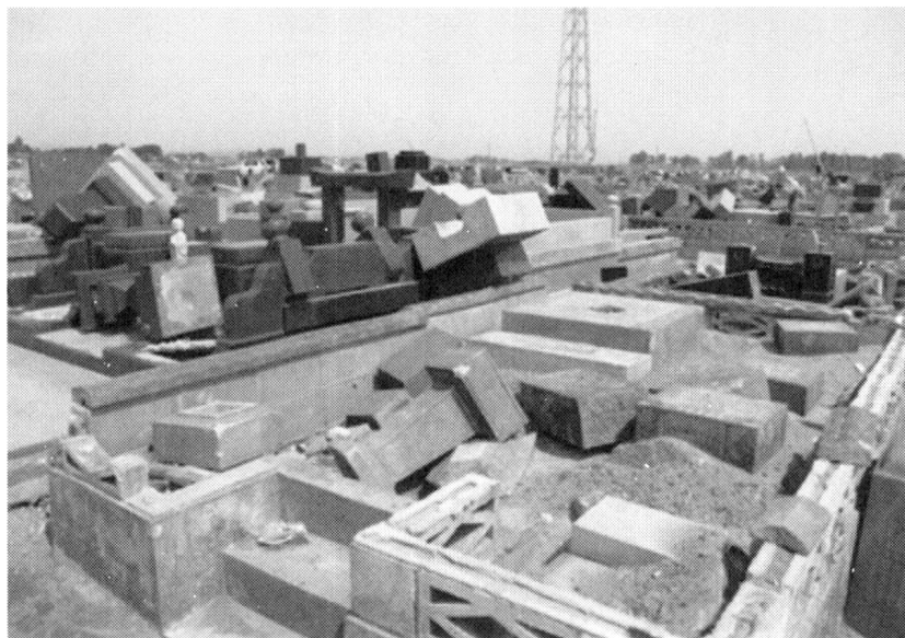
〈写真3〉 津波で倒壊した寺院墓地
