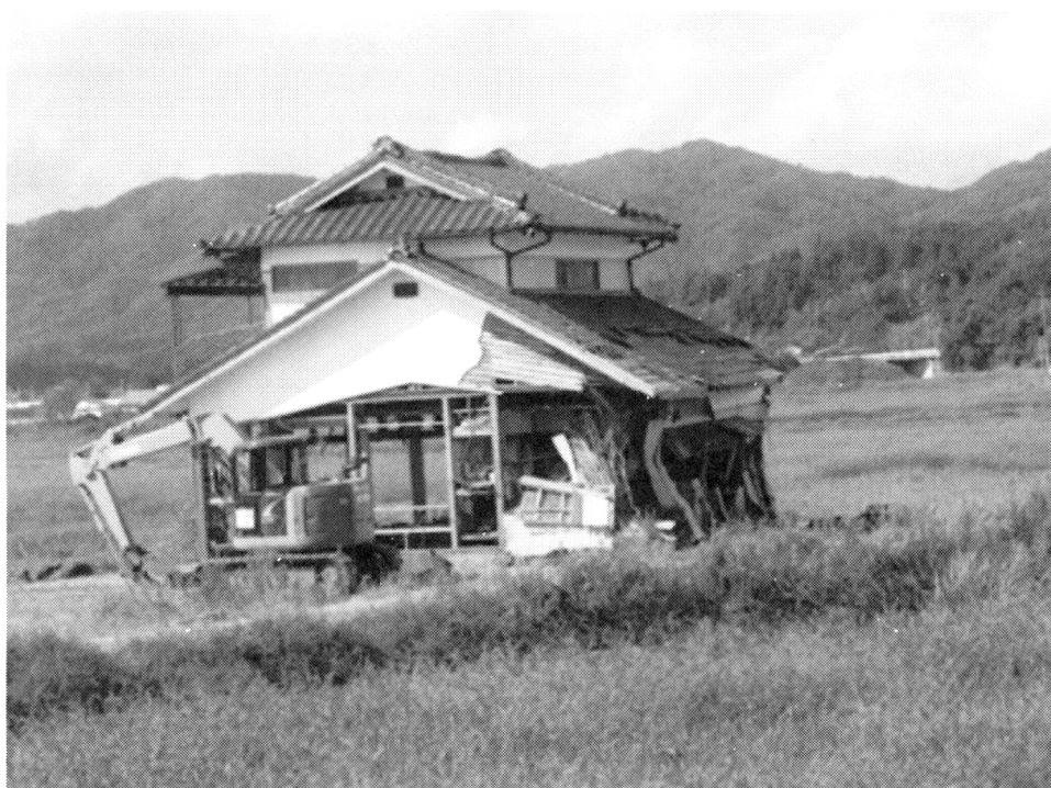
〈写真1〉 一階が流された民家
