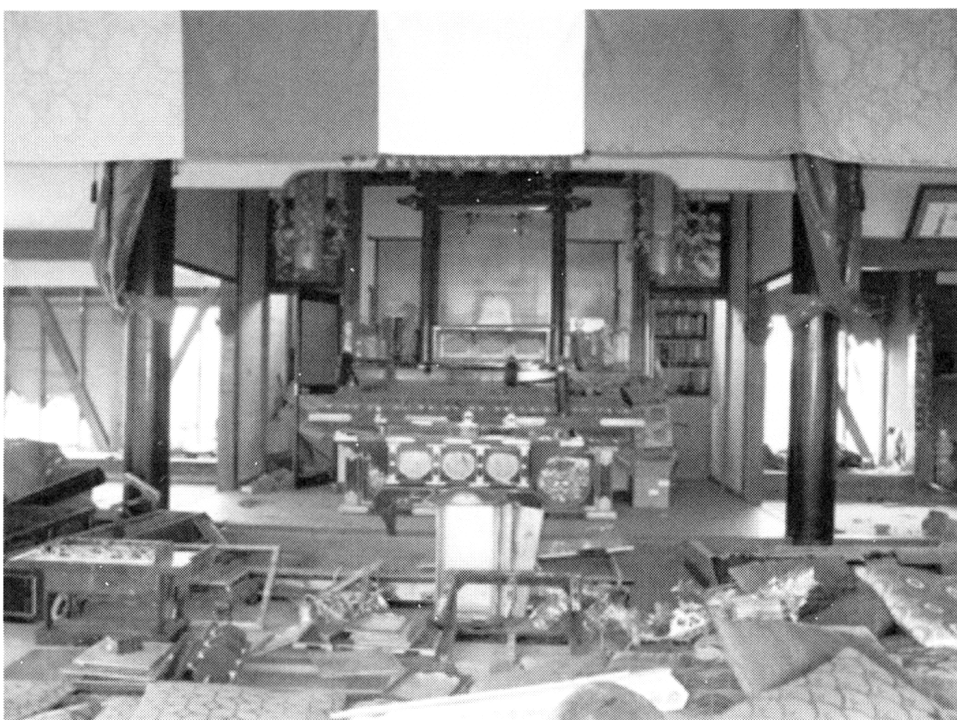
〈写真2〉 津波で被災した寺院の本堂内部
