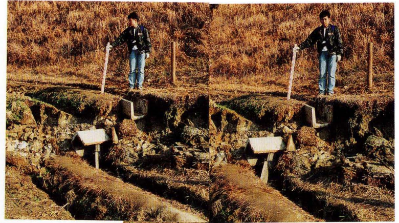
写真24. 地点㉑. 田の畦道や水路の切断・変位状況 (ステレオ写真)
