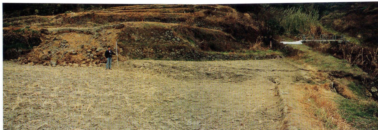
写真29. 地点④. 大川の水田に現れた断層 Photo. 29 Fault scarp of paddy field at Loc ④, Okawa
