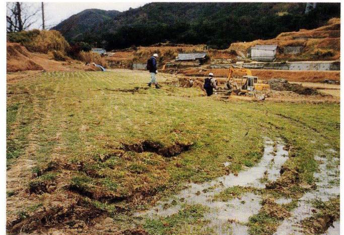
写真47. 地点㉖. 水田の撓曲状変形（後方はトレンチ地点） Photo. 47 Flexural deformation of paddy at Loc ㉖. Excavation point in the distance
