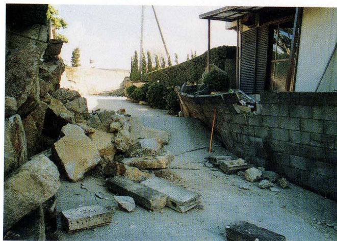
写真53. 地点⑧. 石垣の切断と排水溝の曲がり
