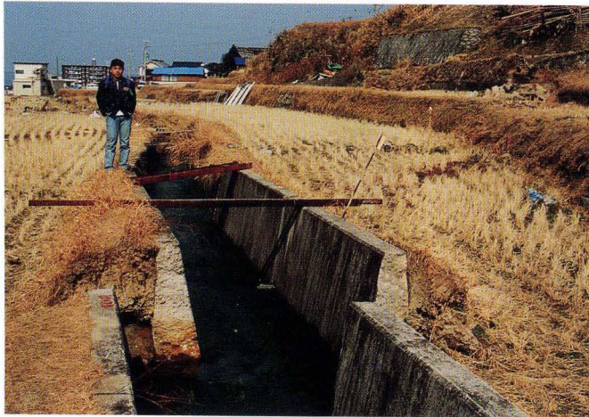
写真44. 地点㉔. コンクリート製水路壁の切断と水平変位 Photo. 44 Right lateral offset of concrete waterway at Loc ㉔
