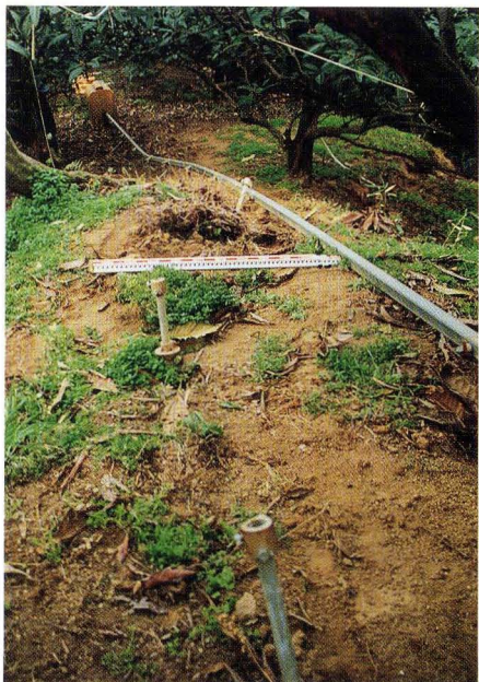
写真33. 地点④. 右ずれによって ひきちぎられたモノレール軌 道
