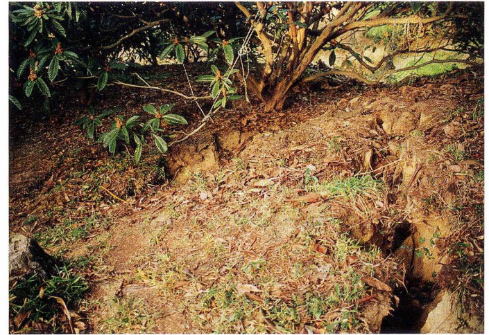
写真18. 地点㉓. 開口亀裂による陥没
