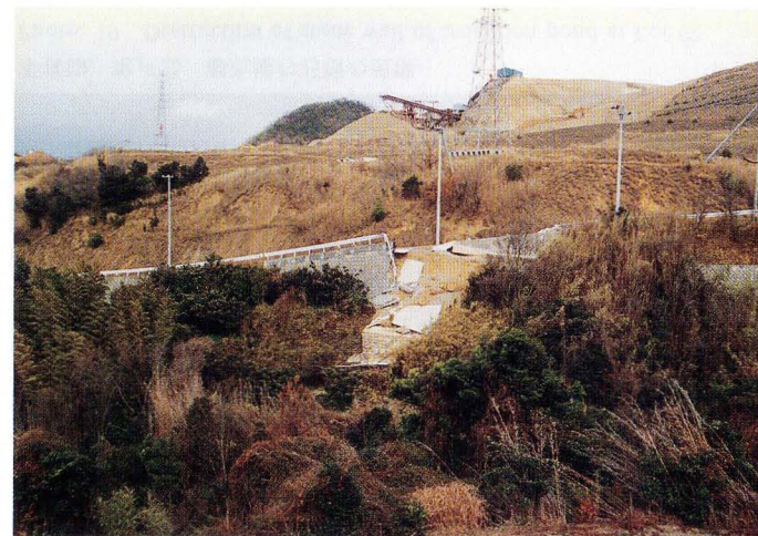
写真22. 地点㊹. 簾川北岸の断層通過状況
