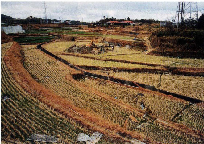
写真45. 地点㉕. 梨本付近の水田に連続する断層（北から南をみる） Photo. 45 Surface rupture traced into paddy near Nashimoto. View from Loc ㉕ looking to south
