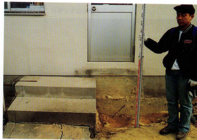
写真54. 地点⑧. 右ずれによる階段の移動
