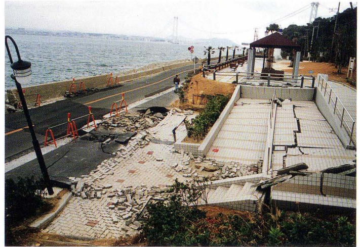
写真2. 地点①. 江崎公園のタイル破壊状況 Photo. 2 Destruction of tiled ground at Loc ①
