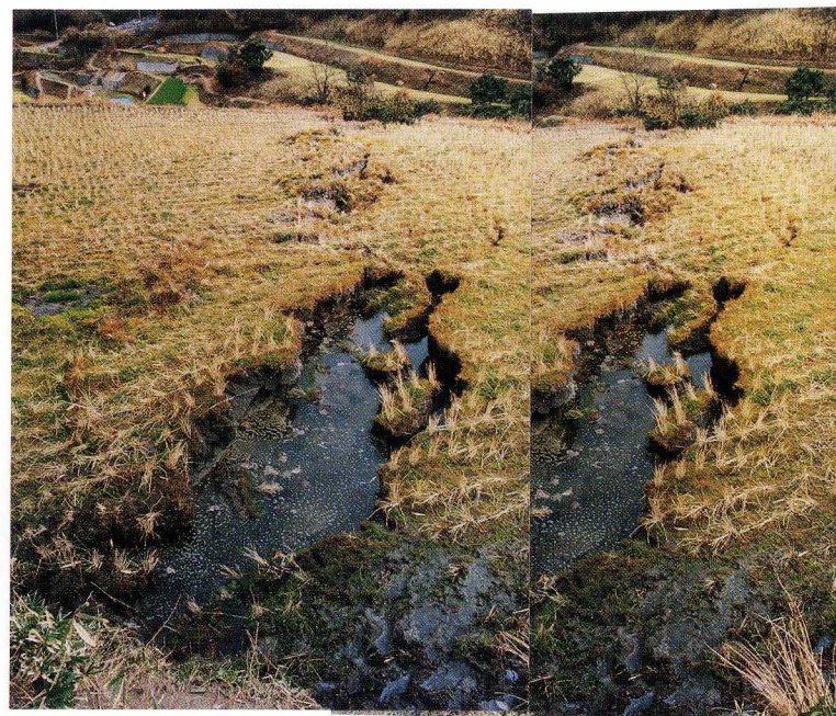
写真13. 地点⑱. 開口による陥没凹地 (ステレオ写真)
