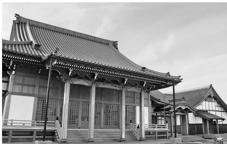
【写真6】善重寺新本堂（完成間近・知多市）
